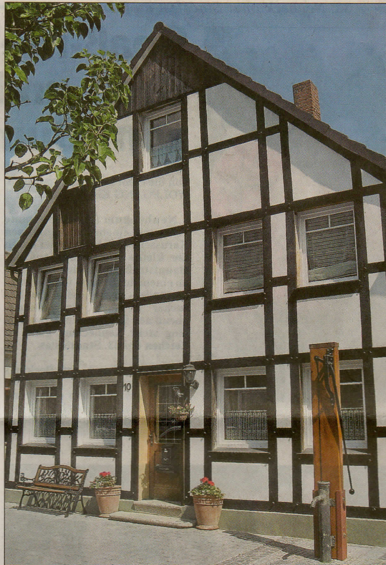
Auch dieses Haus in der Bergstraße brannte 1862 ab. Nach etlichen Veränderungen wurde es liebevoll restauriert. Auch die Gemeinschaftspumpe hatte seinerzeit Schaden erlitten, denn nach dem Brand wurde sie ebenfalls neu errichtet. Im Zuge der Straßenbaumaßnahmen wird sie zurzeit wiederum instand gesetzt. Bild: Schürbüscher
